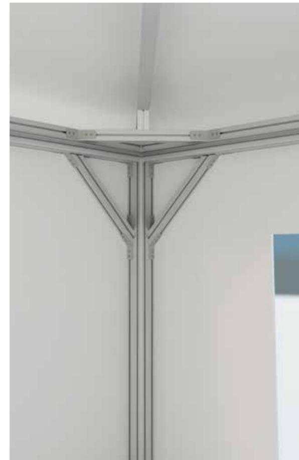
Robuste Aluminiumprofile mit einer Stärke von bis zu 80 x 80 mm.
